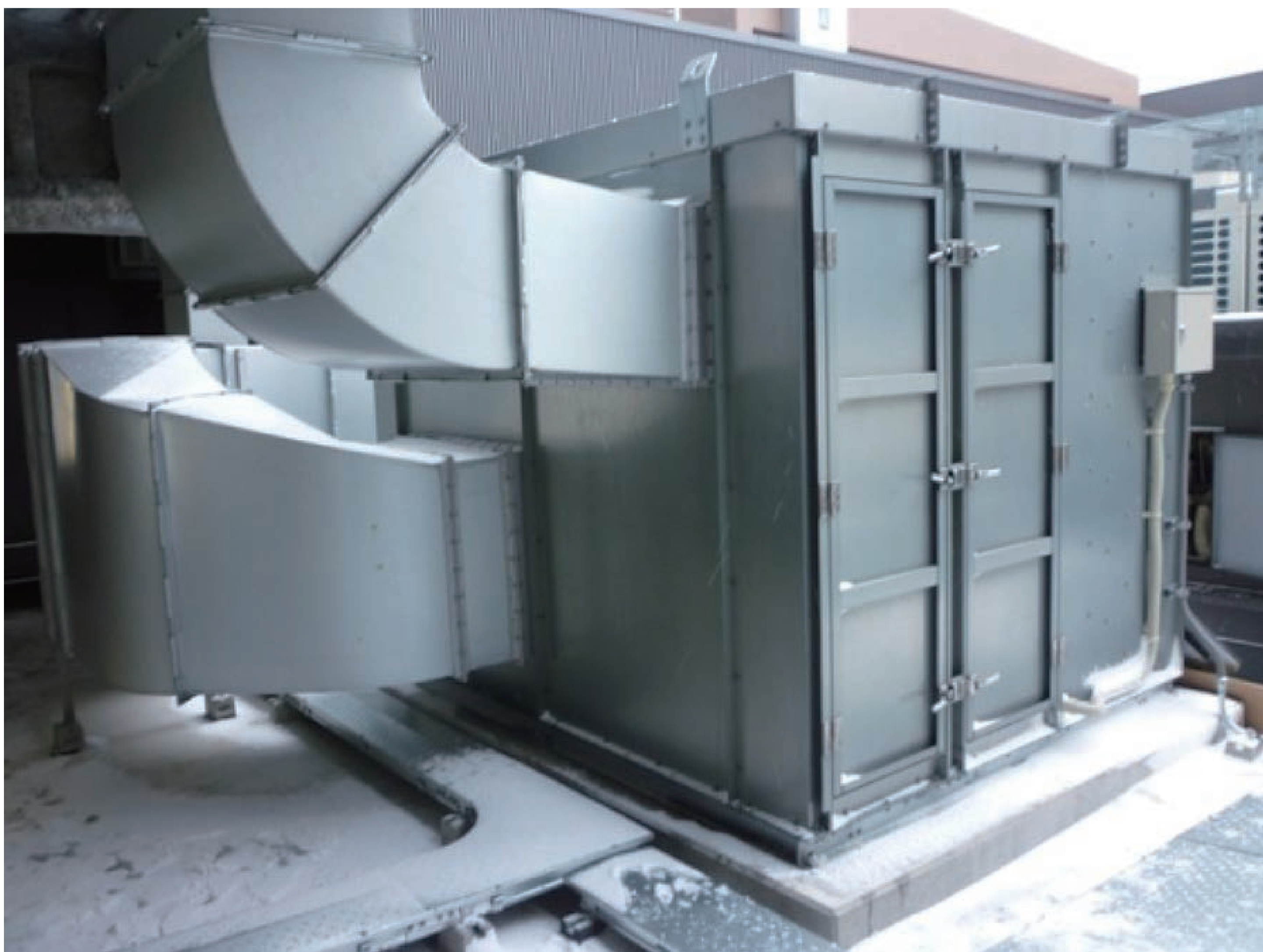
▲屋上設置型光触媒脱臭装置:新潟日報社屋 飲食店排気脱臭
